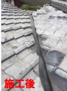
今回ご依頼頂いたS様邸は、台風被害のための屋根点検で、穴を発見。屋根瓦修繕に合わせて、谷樋もステンレス製に取替ました。最近の樋はステンレス製で、酸性雨でも大丈夫です！
