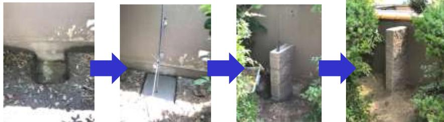
壁に穴をあけ、鉄筋で固定。この後、鉄板を貼り付けてブロック塀を固定します。
