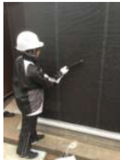
↑左工事手伝い
