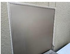
給排水管がある壁は水がしみ、ふわふわの状態になっていました。壁の一部を切り取り、給水管の補修をさせていただきました。
